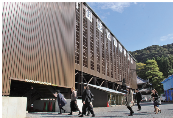
知恩院御影堂修理現場
