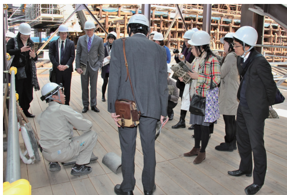
知恩院御影堂修理現場
